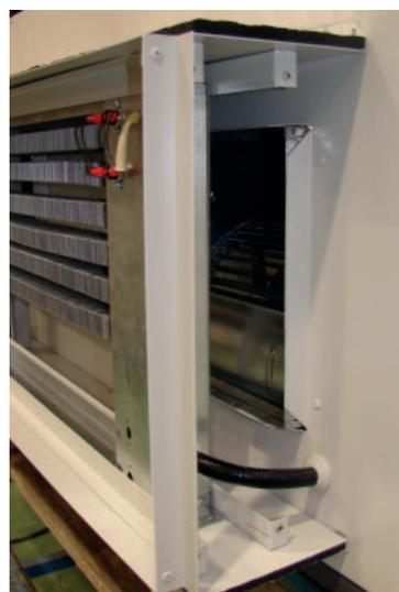
Étape 4 : fermer le panneau d'accès. La sortie est prête pour la pose de la gaine.
