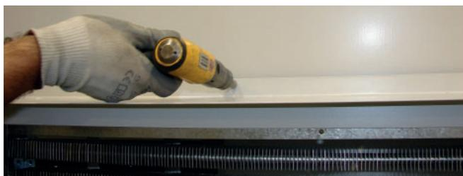
Étape 3 : insérer le flexible dans le perçage effectué pour le raccordement à l'armoire électrique intérieure de l'unité.
