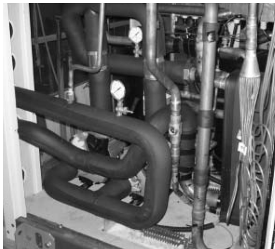
Esempio di un gruppo ILDC 240 con kit 2 pompe singole e kit valvole di regolazione
