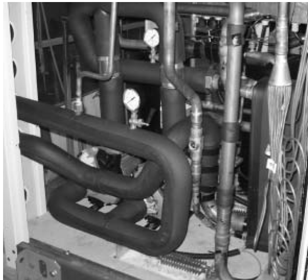
Exemple d'un ILDC 240 avec kit 2 pompes simples et kit vannes de réglage Example of an ILDC 240 equipped with the 2 single water pumps kit and the adjustable valves.
